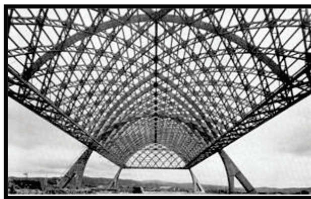
Fig.b Hangar construit à partir d'éléments préfabriqués en béton armé pour l'aviation italienne, 1940, ing. P.L. Nervi
